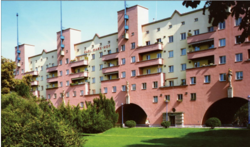
Karl-Marx-Hof, 1926-1930 erbaut und 1988-1992 saniert, bekanntester Gemeindebau mit 1.272 Wohnungen, über 1 km lang mit Kindergärten, Bädern, Jugendheim, Bibliothek. (Screenshot: Wohnservice Wien )
