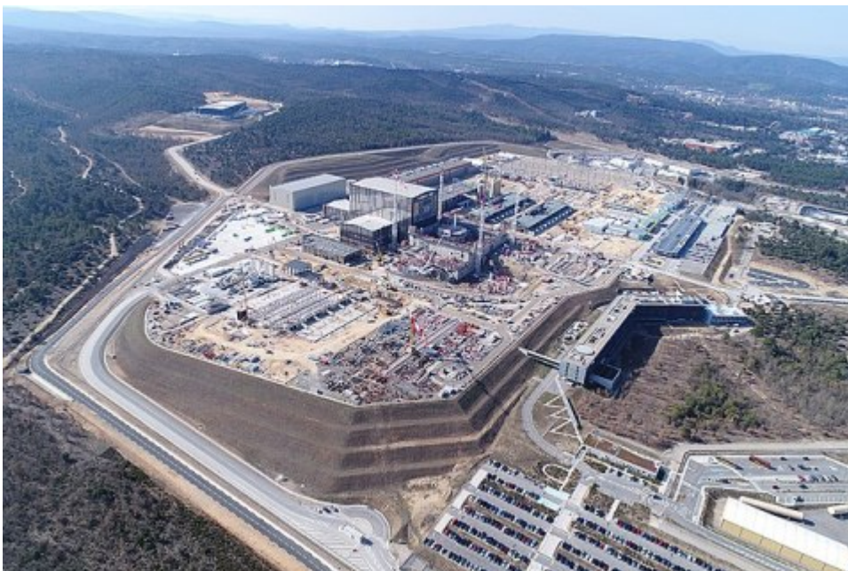
Luftbild des ITER-Geländes in der Bauphase (2018)
