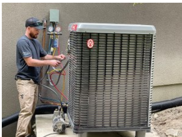
Heizungspumpen-Installation (Foto: Phyxter Home Services auf wikimedia commons )
