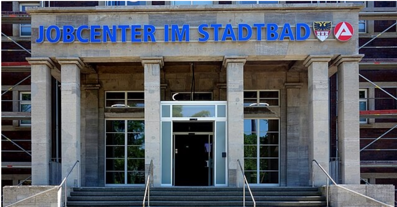
Eingang zum Jobcenter im ehemaligen Stadtbad Hamborn
