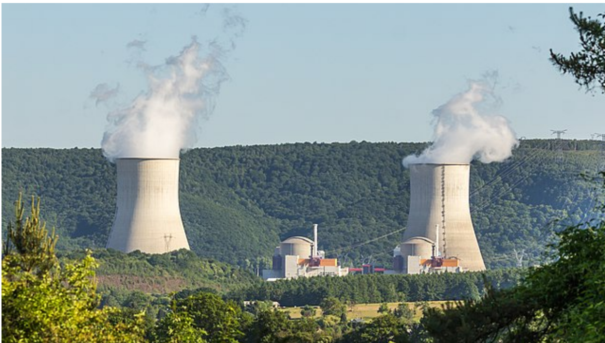
Chooz Nuclear Power Plant (Foto, 2015: Raimond Spekking auf wikimedia commons )
