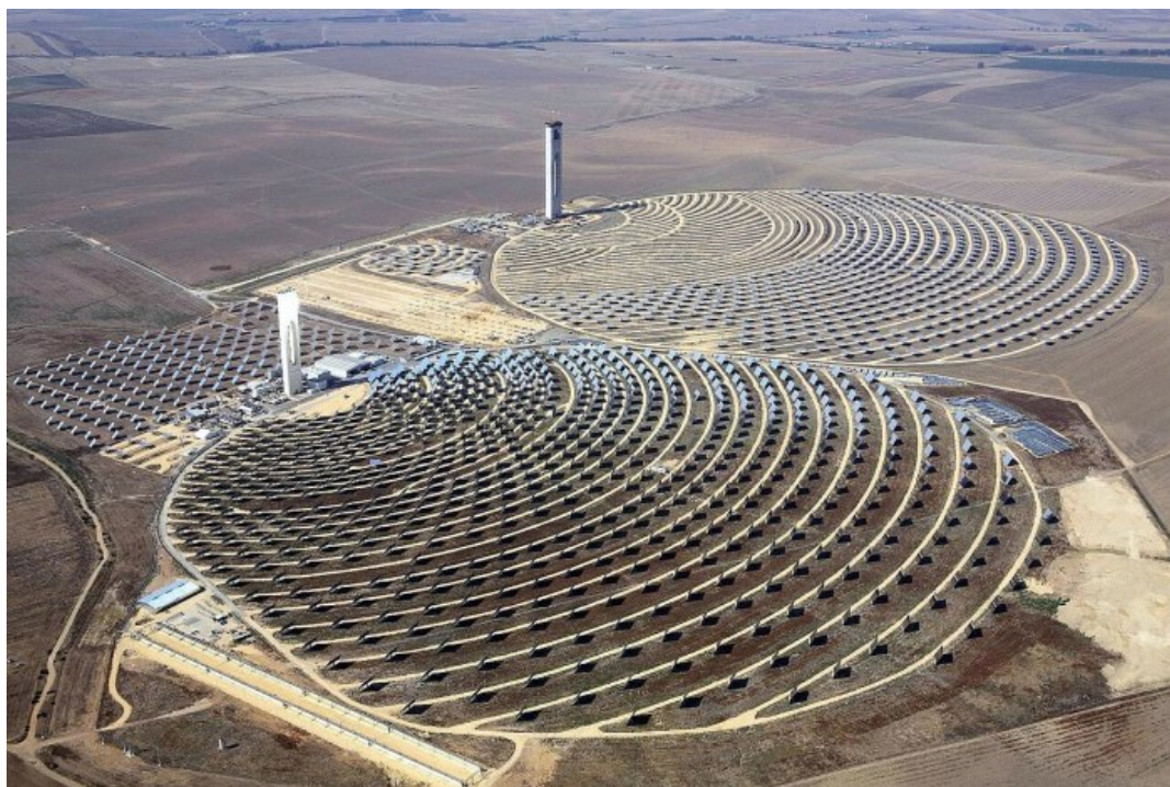
Solarwärmekraftwerk PS10 bei Sevilla (Foto, 2007 : Koza1983 auf wikimedia commons )
